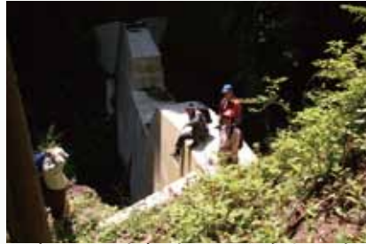
写真8. 一本杉峠へ行く途中の砂防ダム
