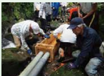
取水口を沢に取り付けているところ
