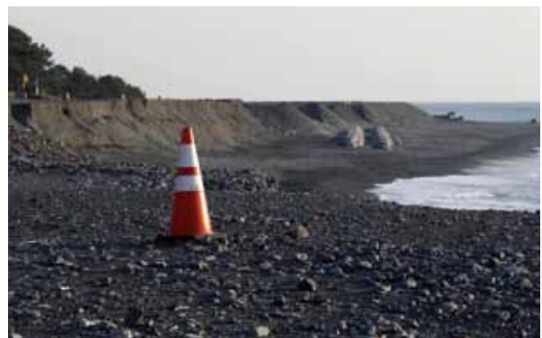
海岸浸食対策として後浜に盛土が積まれる
