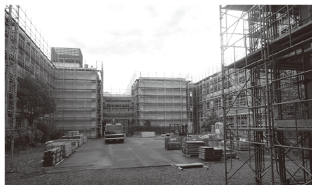
改修中の外構工事
